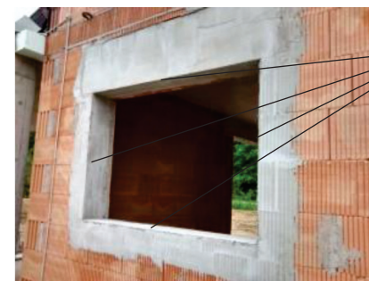
სურათი 22: სათანადოდ მომზადებული ფანჯრის ლიობი ფანჯრის ჩასმამდე.
