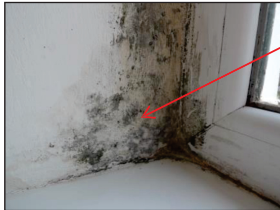
სურათი 40: ფანჯრების შეცვლა საავადმყოფოში გარე კედლების თერმოიზოლაციის გარეშე
