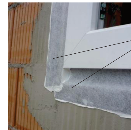
სურათი 23: გარე ჰერმეტიზაციის მემბრანა ბათქაშის შრეზე არის მიწებებული
