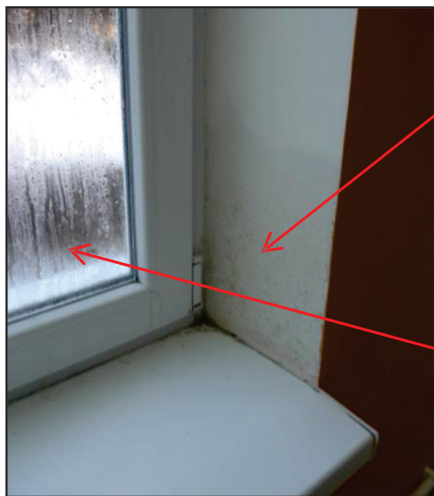
სურათი 41: ფანჯრების შეცვლა სკოლის სასადილოში გარე კედლების თერმოიზოლაციის გარეშე
