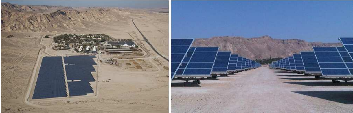
სურ. კიბუცი „კეტურა“-ს მზის პანელების 5 მვტ. სიმძლავრის ელექტროსადგური
