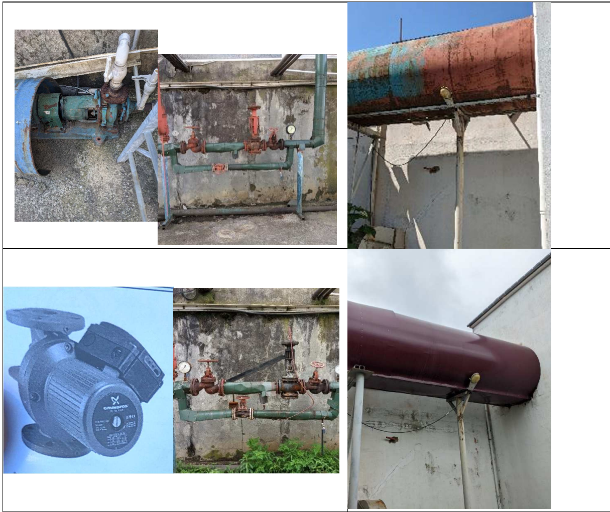
ნახ. 2. კონდენსატის საცირკულაციო ტუმბო, წნევის რეგულატორის სარქველი და კონდენსატის ავზი რესწ ღონისძიებების განხორციელებამდე და მის შემდეგ
